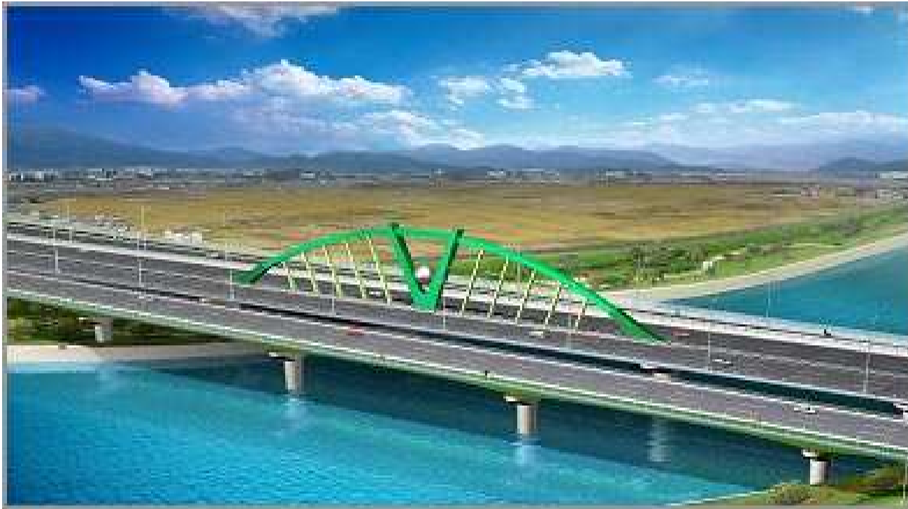
Kuva 4: Silta: laatta-, palkki- ja pilarirakenteita (Uchon, Ranska).
