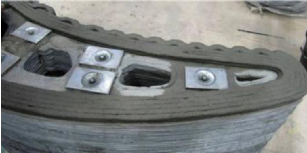
Kuva 10. Tämä on osa CP-tulostimella tehdystä betonipenkistä. Teräskappaleet lisättiin manuaalisesti tulostuksen jälkeen.
