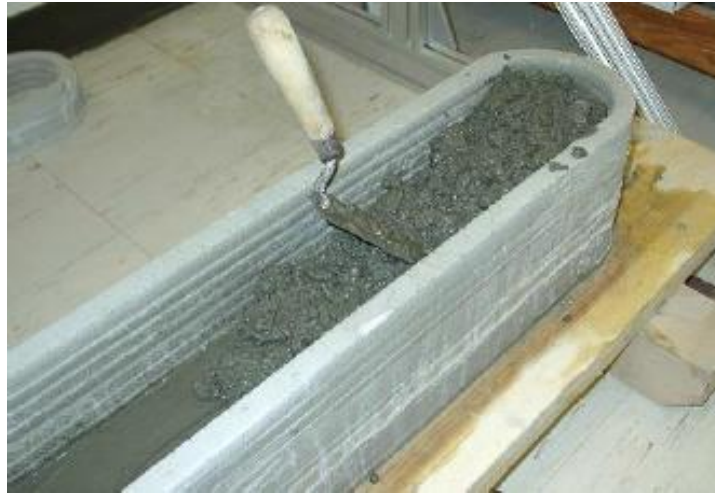
Kuva 8. CC-tulostimen tekemä betonimuotti, johon ollaan parhaillaan valamassa betonia. Huomaa suuri kerroskorkeus muotissa. (Hwang, et al. 2005, s. 5)
